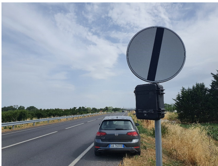
S01A Via Gaetano Baviera (nuova strada Fenile - Fano), verso Via Flaminia 27/07/2021
