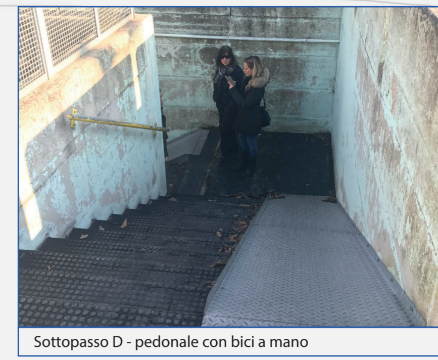
Sottopasso D - pedonale con bici a mano
