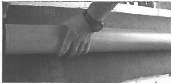
ISOLAMENTO ACUSTICO DI UNA TUBAZIONE DI SCARICO CON TOPPLENTA®
