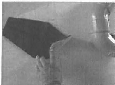
FASI PER L'ISOLAMENTO ACUSTICO DI UNA CURVA DI UNA TUBAZIONE DI SCARICO CON TOPPLENTA®
