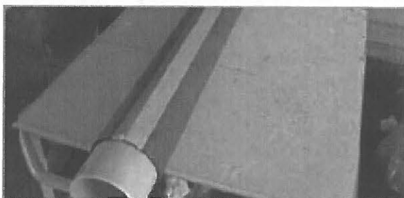
ISOLAMENTO ACUSTICO DI UNA TUBAZIONE DI SCARICO CON TOPPLENTA®
