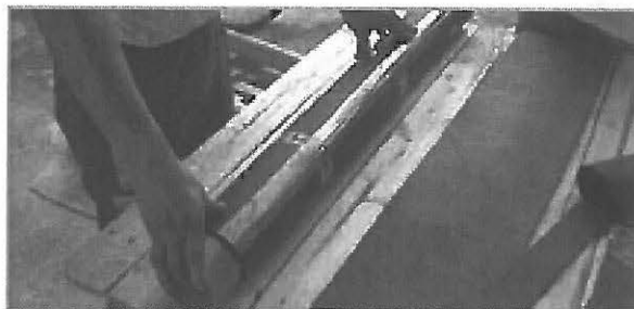
ISOLAMENTO ACUSTICO DI UNA TUBAZIONE DI SCARICO CON TOPPLENTA®
