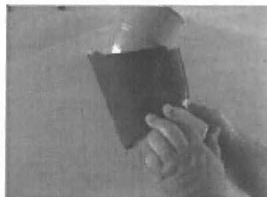
FASI PER L'ISOLAMENTO ACUSTICO DI UNA CURVA DI UNA TUBAZIONE DI SCARICO CON TOPPLENTA®
