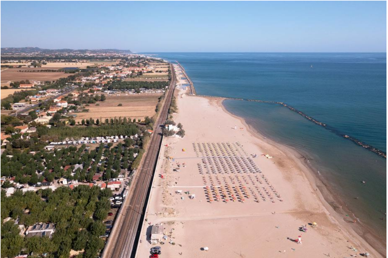
Figura 7 - Vista aerea del tratto di Metaurilia: ben evidenti le cesure infrastrutturali, lo sviluppo urbanistico lungo l'asse della SS16 e l'erosione costiera
