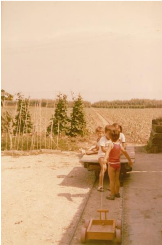
Figura 11 - Negli anni '50 per facilitare la raccolta dei cavoli le varie famiglie realizzarono un binario a scartamento ridotto (con una sezione di circa 60 cm) che correva longitudinalmente al lotto, per il trasporto del raccolto tramite un carrello di legno che correva su queste piccole rotaie e che andava spinto a braccia.
