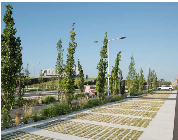
Figura 24 – Esempio di “parcheggio verde”: parcheggio dell'outlet Honfleur Normandy in Francia, Edouard François, e schema planimetrico di parcheggio con sup. minerali 70-75% - sup. vegetate 25-30% - ombra:70-75% (manuale SOS4life – Regione Emilia Romagna)
