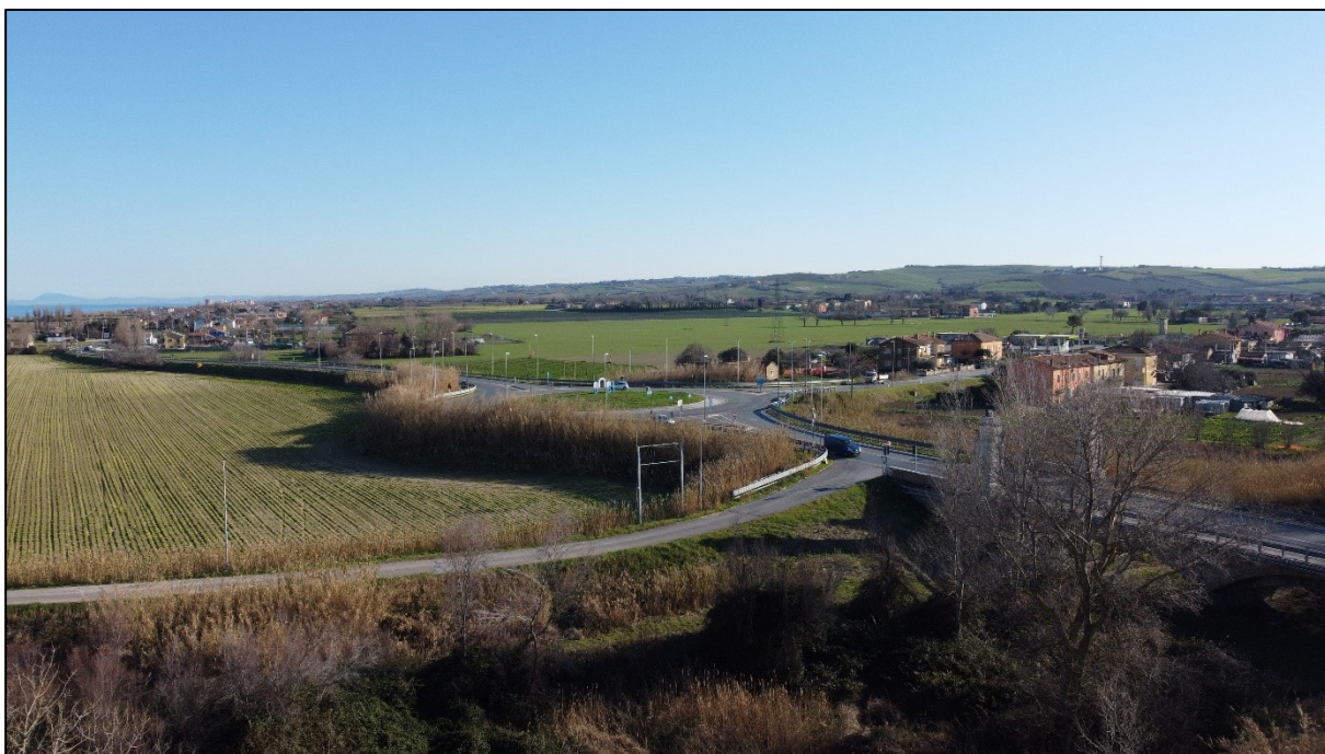
Fotografia 3 - Ripresa fotografica del tratto di SS16 in prossimità del Fiume Metauro.
