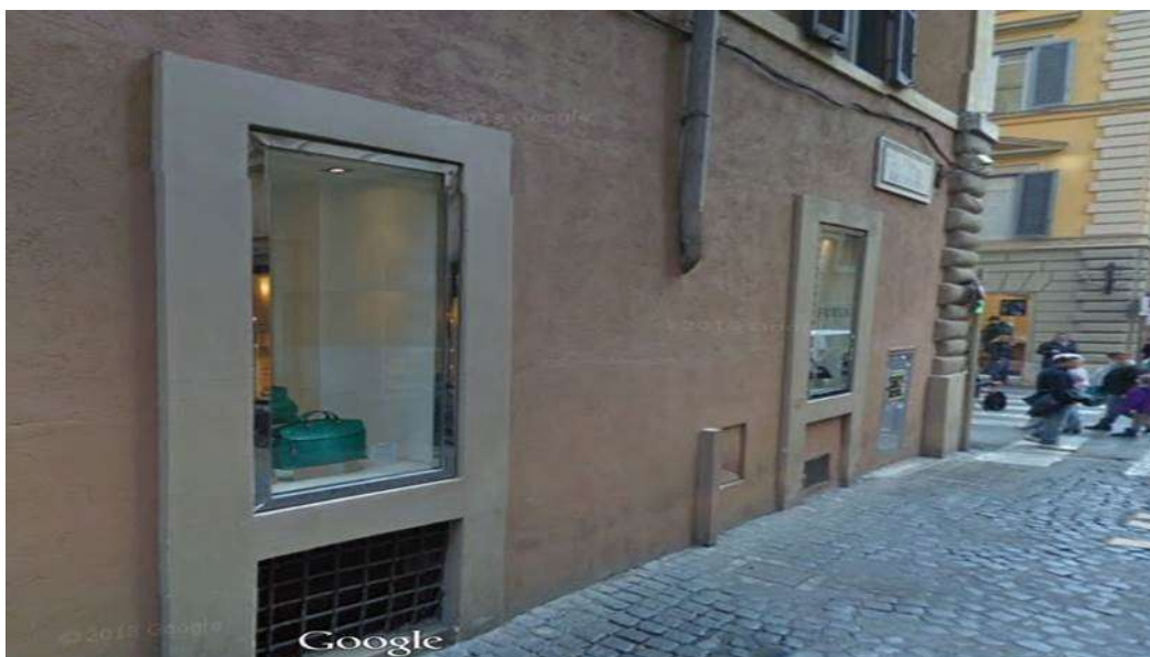
Figura 29 - Esempio di accessi rialzati a più di 25 cm dal livello stradale. Via Belsiana, Comune di Roma - Fonte Elaborazione su Google Earth
