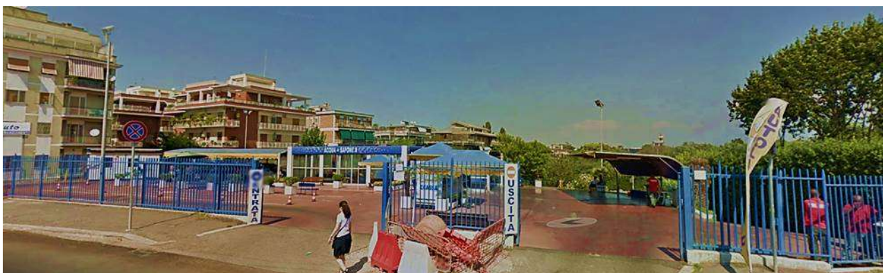
Figura 39 - Esempio di area recintata con un'attività di auto lavaggio, Via Laurentina, Comune di Roma - Fonte Elaborazione su Google Earth
