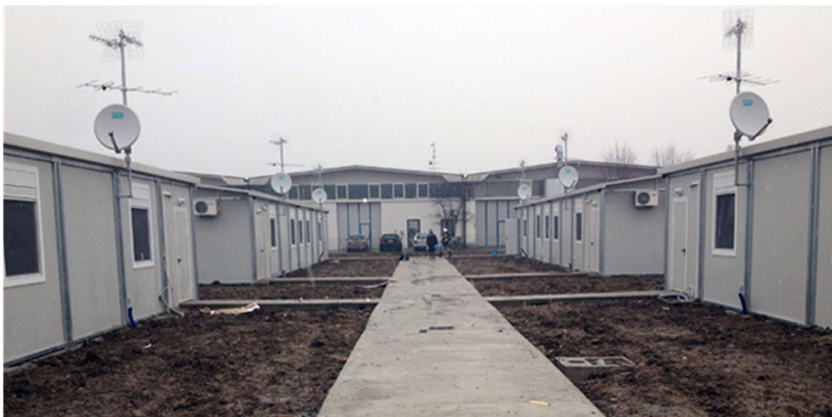
Figura 42– Esempio di prefabbricati modulari abitativi rimovibili. Novi di Modena e Rovereto di Novi (MO)
