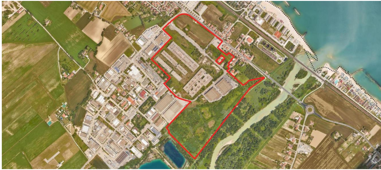
Figura 7-1: Stato di fatto dell'area
