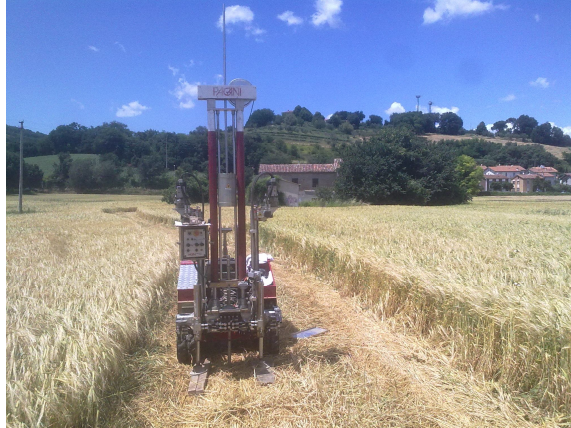
Foto postazione DPSH4
