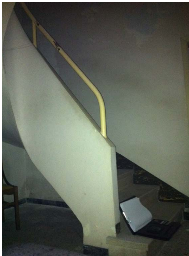
Fig. 4 Scala interna (parapetto al P.T.)
