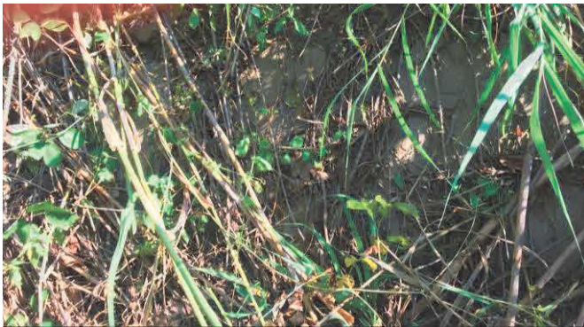
Particolare del rivestimento in cemento di parte dell'alveo
