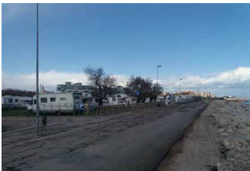
2-VISTA DA SUD A NORD
