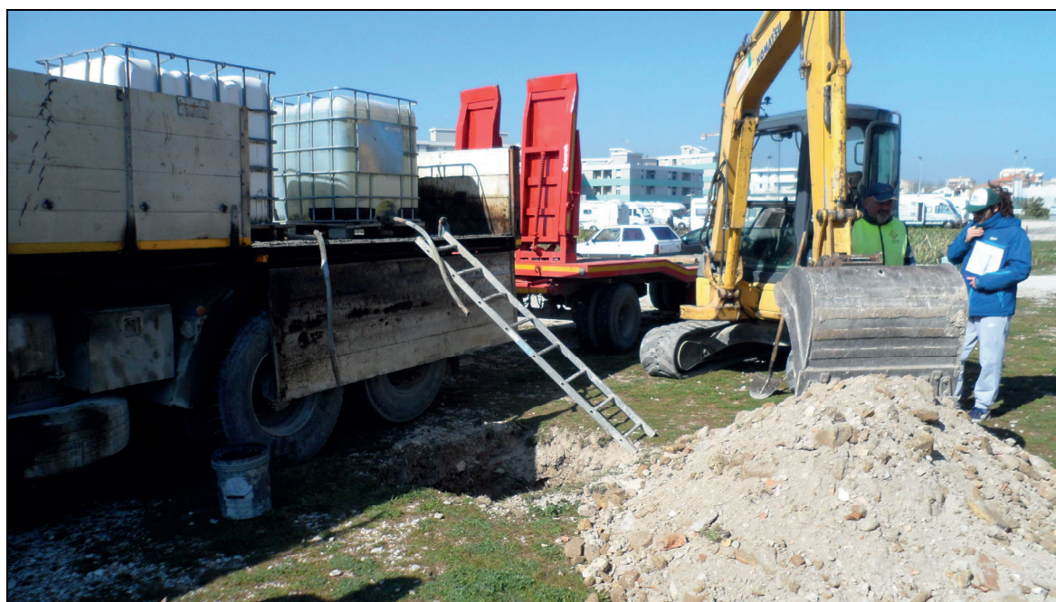
Allestimento prova di permeabilità
