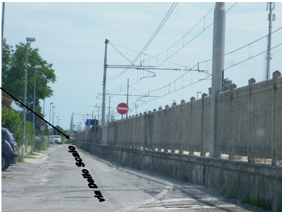
Figura 3 – Zona di recapito della condotta di progetto sulla vicina fognatura su via Dello Scalo previo realizzazione di un nuovo pozzetto
