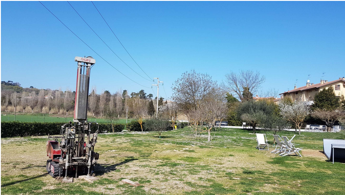
Postazione prova penetrometrica statica C.P.T.- 1
