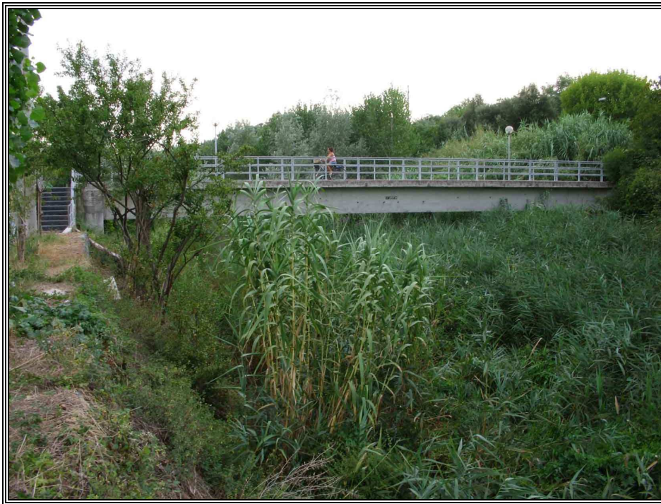
Foto 1: Tratto direttamente a valle della passerella pedonale
