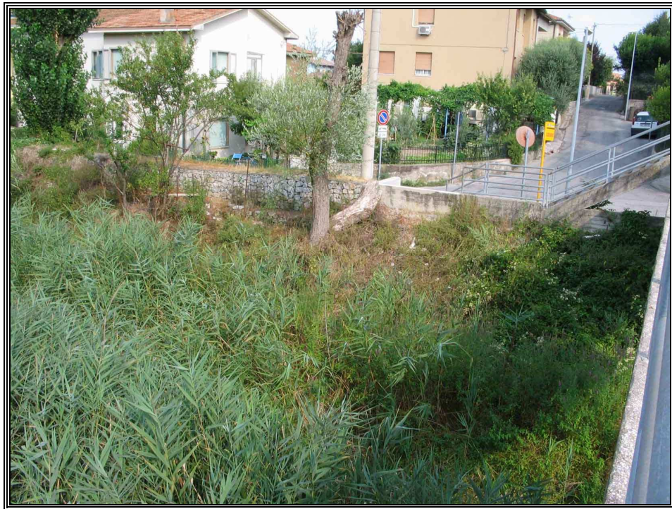
Foto 3 : Vista della sponda destra a valle della passerella
