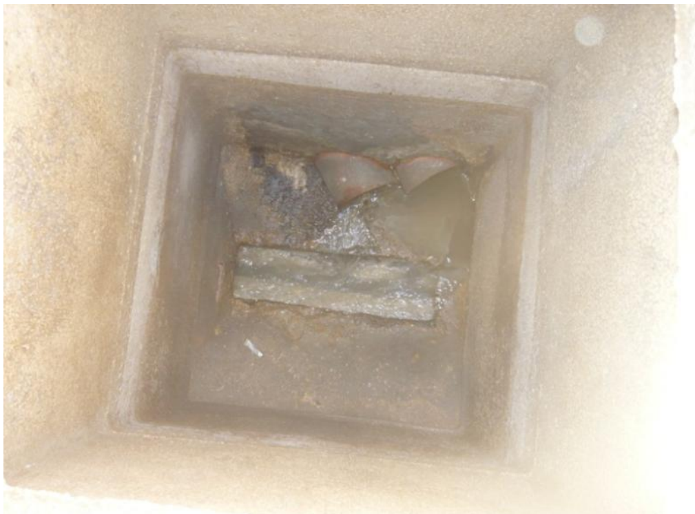
Foto 1 - Apertura pozzetto P15 via del Moletto
