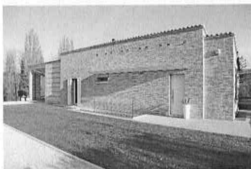
foto nr. 46 Ristrutturazione accessorio agricolo con cambio destinazione d'uso in casa, Fermignano (PU)
