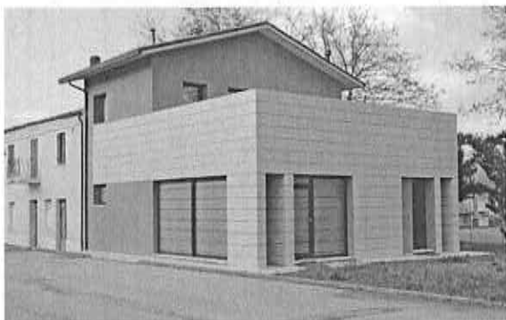
foto nr. 14 Restauro di casa privata in Schieti di Urbino (PU)
