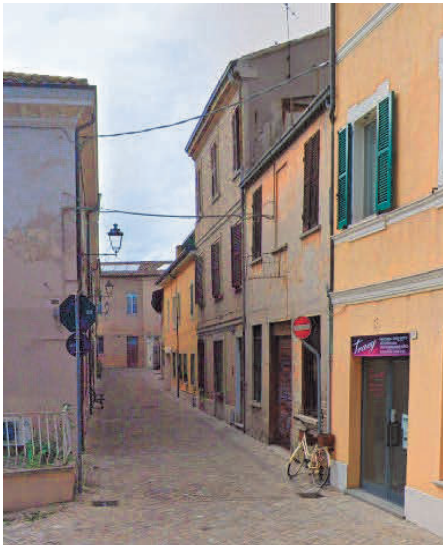
1. IL CONDOMINIO MINIMO DI VICOLO GALLIZI 8, 10 DA VIA GARIBALDI (da GOOGLE)
