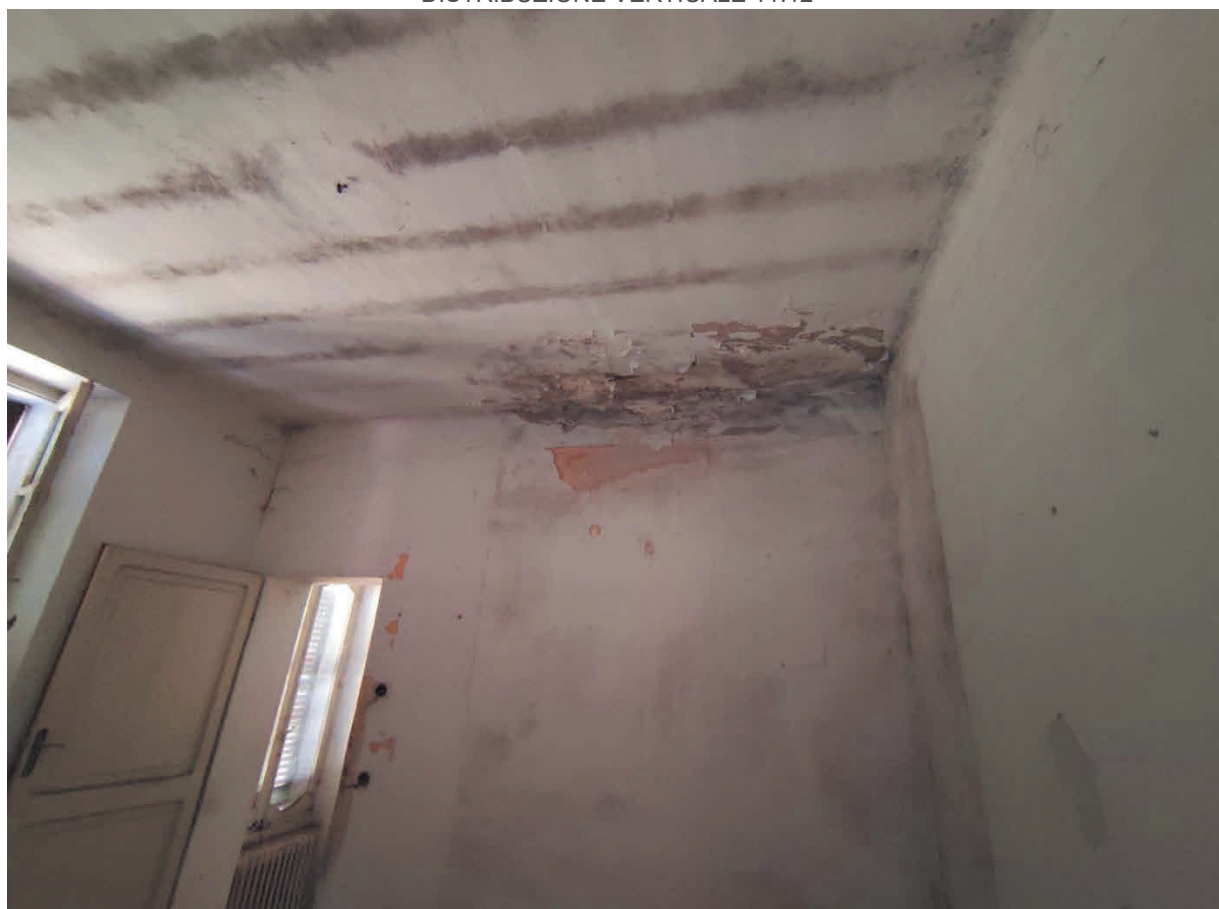
13. LOCALE SOPRA AL DEPOSITO
