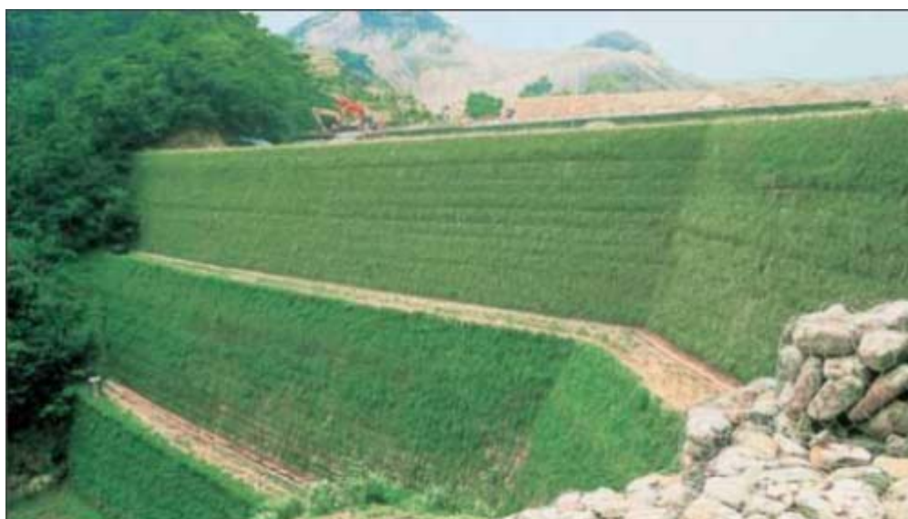
Figura 14: Esempio di terre armate realizzate
