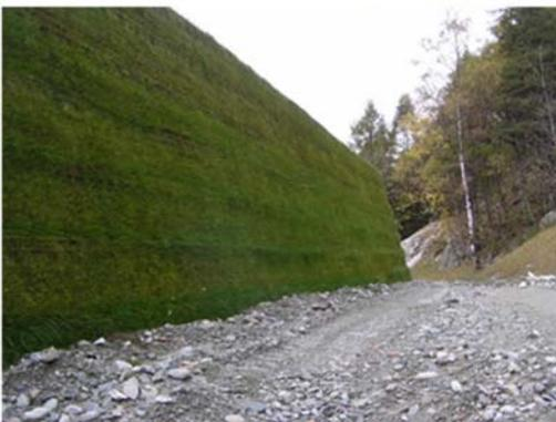
Dove invece la scarpata è avvistabile da chi si trova nei pressi della strada è previsto l'inserimento opere di sostegno realizzate mediante terre armate: tali opere d'arte assumono pendenze semi-verticali (1:10) e si presentano con un manto verde inerbito realizzato grazie alla presenza di una matrice di tessuto che trattiene semi e fertilizzanti, evitando anche il fenomeno di dilavamento.
