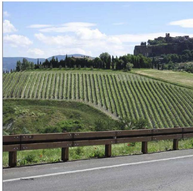
*Figura 3-8: Barriere in acciaio corten e legno*
