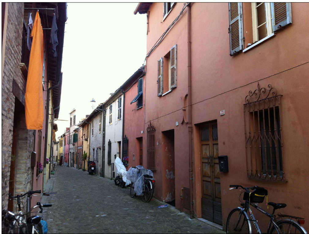
FOTO 5 - Vista prospetto fabbricato
