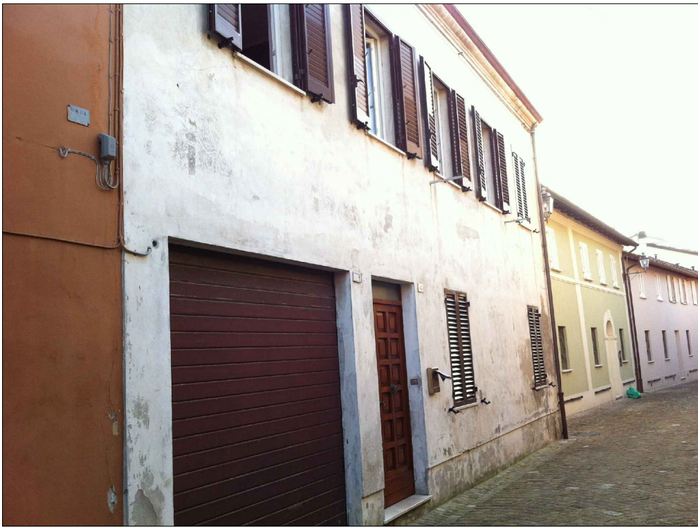
FOTO 3 - Vista prospetto fabbricato confinante
