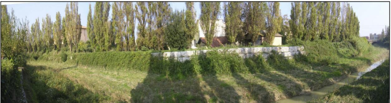
*Fig. 3a – Argini artificiali lungo il torrente Arzilla*
