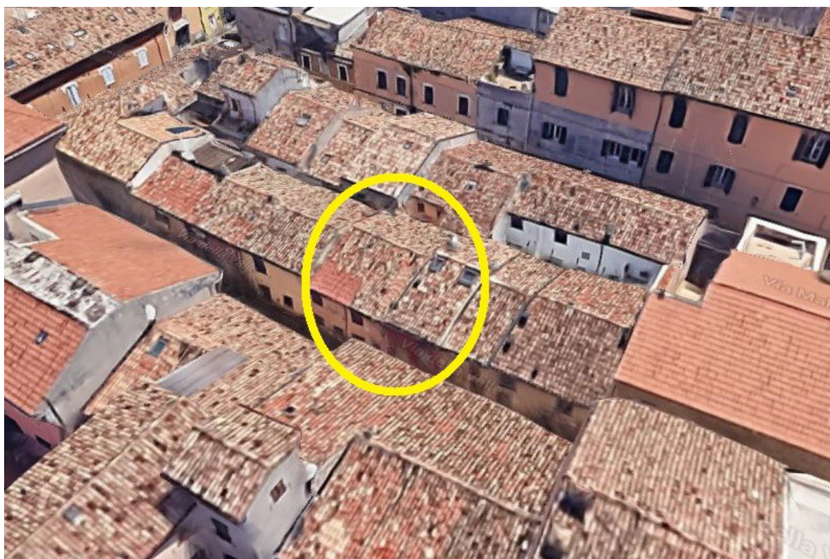
Figura 4 - Foto aerea (stato attuale)
