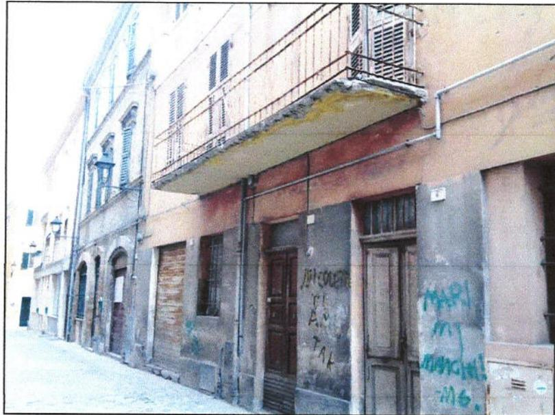
*Vista del fabbricato da via De' Petrucci (si notano le porte d'ingresso di ridotte dimensioni, mancano collegamenti con aree di adeguata altezza per l'estensione verticale delle macchine penetrometriche).*
