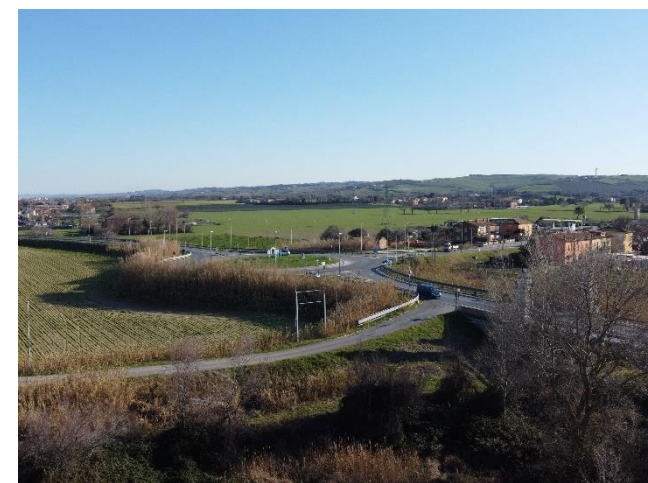
Vista complessiva della rotonda e dell'attacco al ponte
