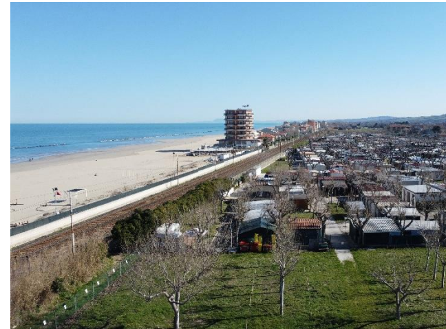
Vista del punto di attraversamento della ferrovia
