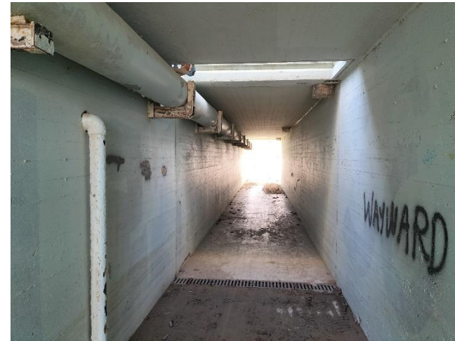
Sottopasso esistente in corrispondenza dell'Hotel Playa
