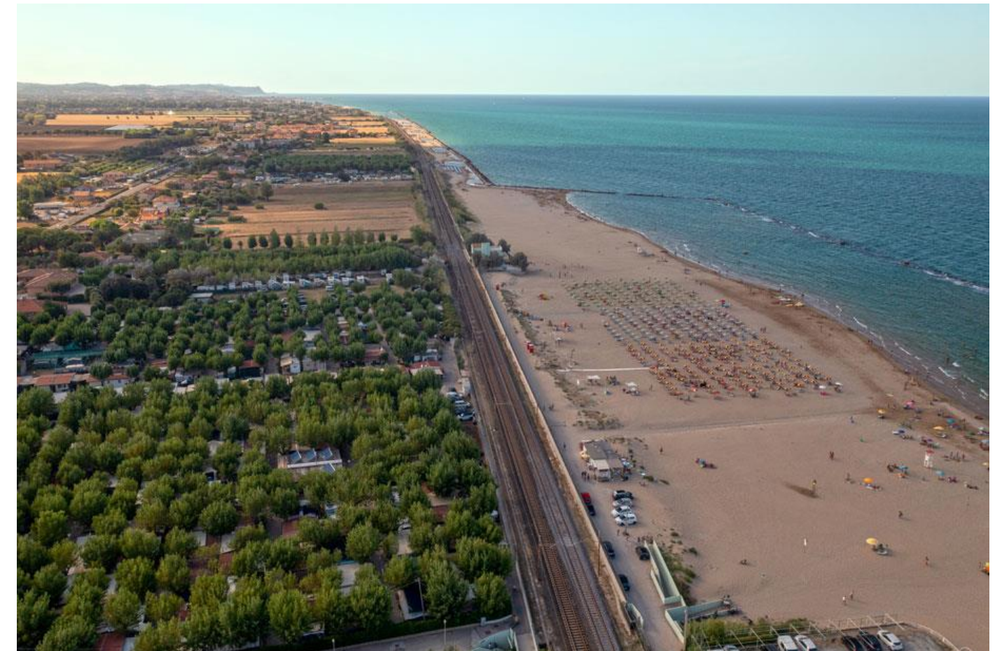
Figura 4 - Vista del tratto di spiaggia tra l'Hotel Playa e l'abitazione lato mare rispetto alla ferrovia, visibile la strada che prosegue fino ad essa
