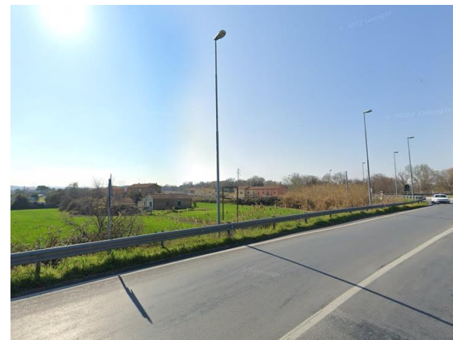
Tratto in rilevato della Strada Statale Adriatica
