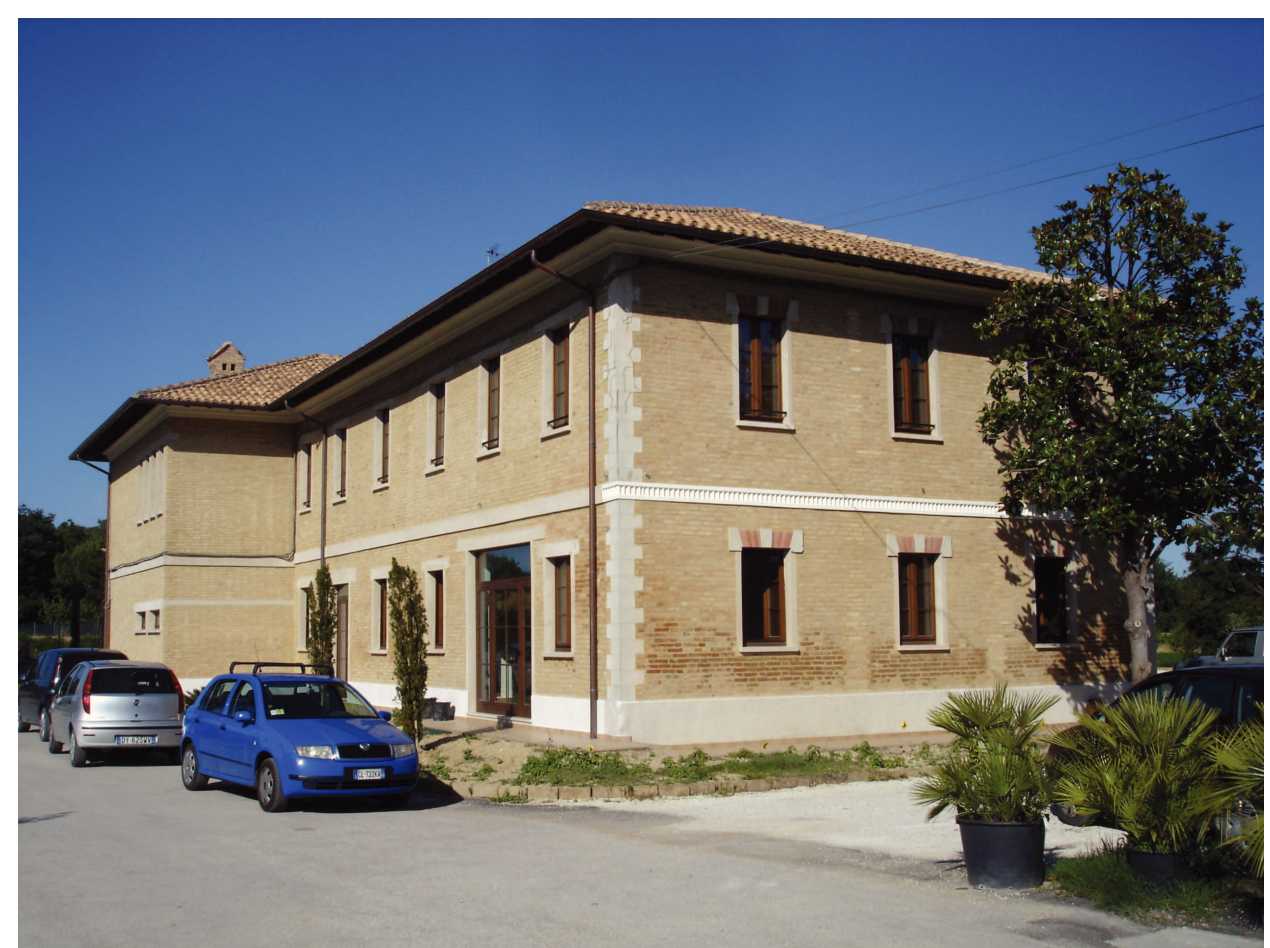
Immagine 1 - vista del fronte laterale destro e retro
