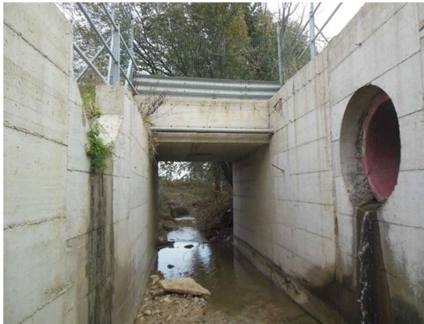
Fig. 7–Attraversamento di Strada di Mezzo a valle dell'Autostrada
