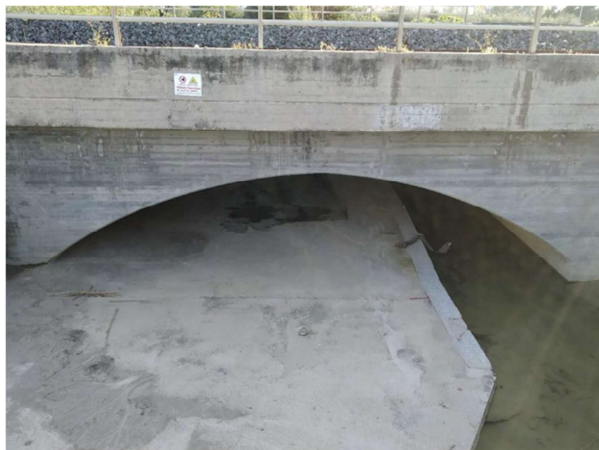
Fig. 13–Vista dell'attraversamento ferroviario sul Rio Crinaccio
