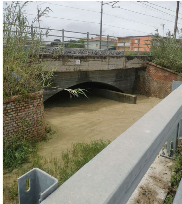
Fig. 15–Attraversamento ferroviario al km 166+023 – Vista di valle – piena maggio 2023
