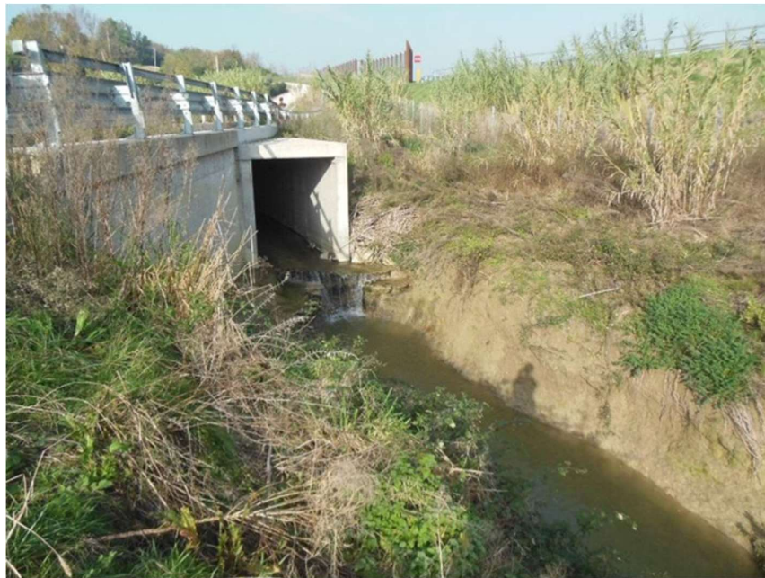
Fig. 5–Attraversamento della strada comunale a monte dell'autostrada
