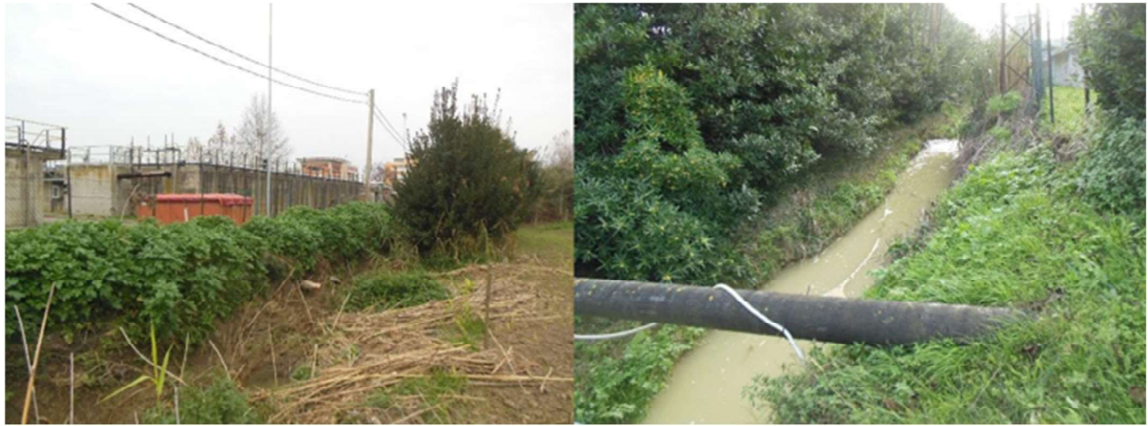
Fig. 10–Foto del Rio Crinaccio nella zona del depuratore di Attraversamento Sasso, vista da monte e da valle
