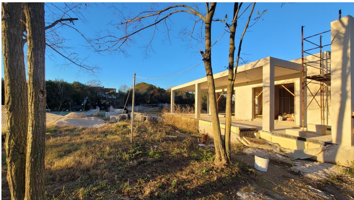
Fig. 6/11- Vista verso il limite sud del sito.
