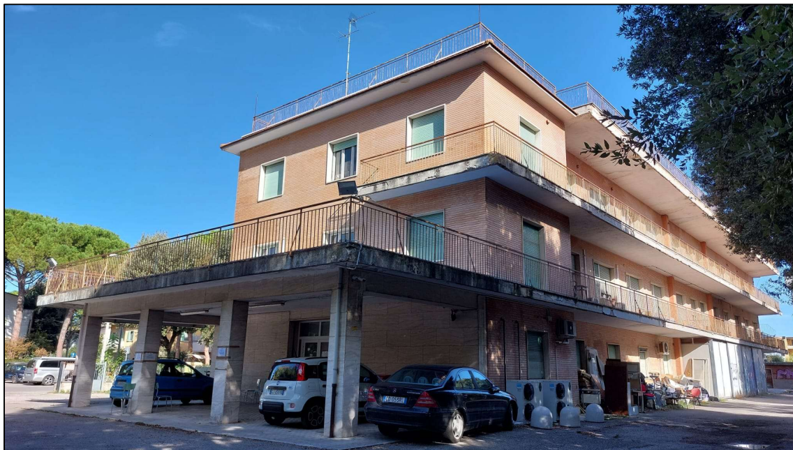
“Ospedaletto” oggetto di demolizione
