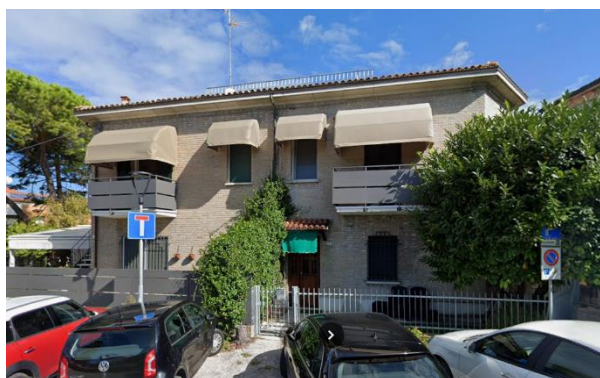
L'edificio in oggetto
