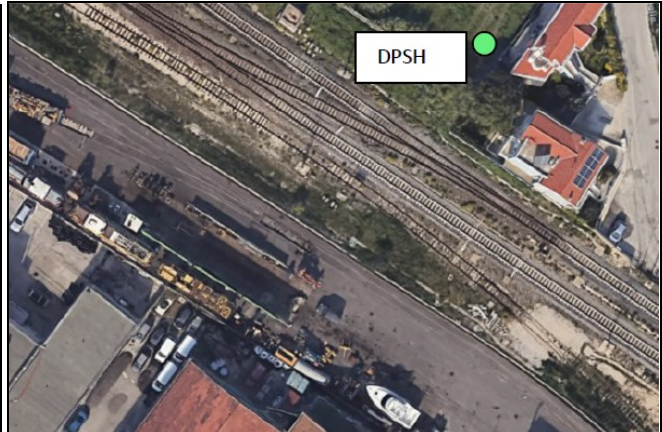
Area lavaggio con ampliamento capannone verniciatura
