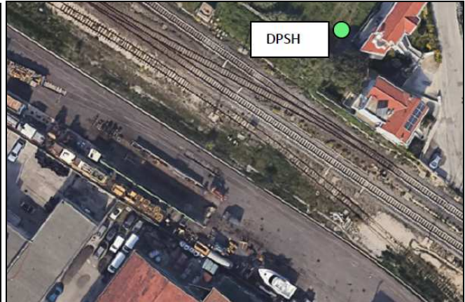
Area lavaggio con ampliamento capannone verniciatura
