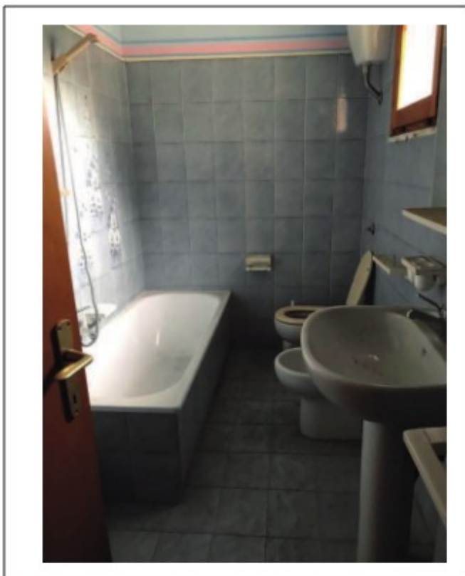
FOTO 10 – interno, piano secondo
