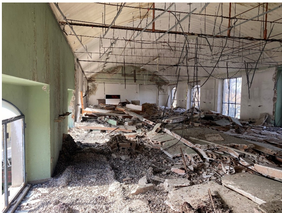
Figura 26: Fotografia stato attuale interno all'edificio 2, piano secondo
