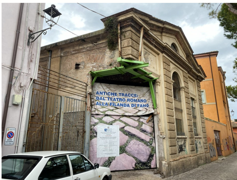
Figura 27: Fotografia stato attuale facciata su via De Amicis con angolata demolita nel 2001
