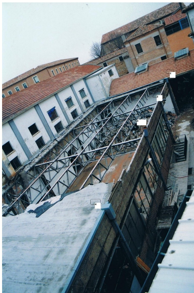
Figura 23: Foto risalenti alla demolizione del capannone a struttura metallica realizzato dalla ICOMAS nel gennaio 2001
