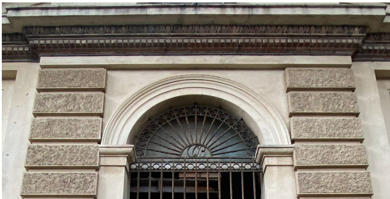
Figura 6: iniziali del fondatore della ex Filanda, Carlo Bosone, impresse nell'inferriata della facciata principale dell'edificio 1
